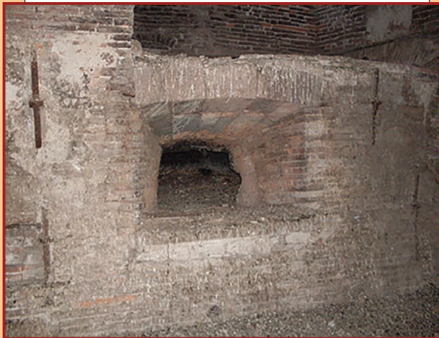
Foto sopra: La Fornace nella sua collocazione. Caratteristica delle fornaci da metallo la bocca di carico del materiale da fondere a forma di "bombardiera".
